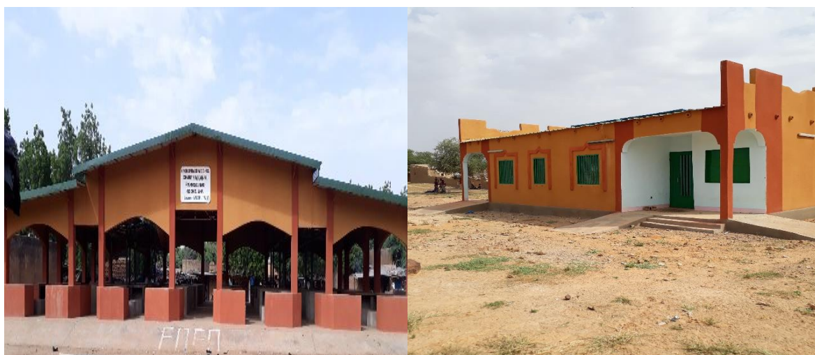
Hall central du marché de Falagountou et Mini-laiterie à Tin Akoff
