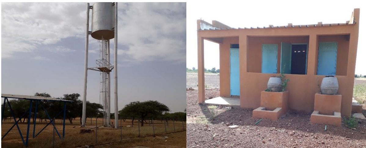
Château d'eau de l'AEPS de Tin-Akoff et latrines à Sebba
