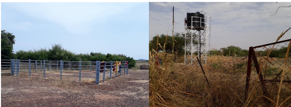
Parc à vaccination construit et site maraicher aménagé dans les communes de Solhan et Markoye
